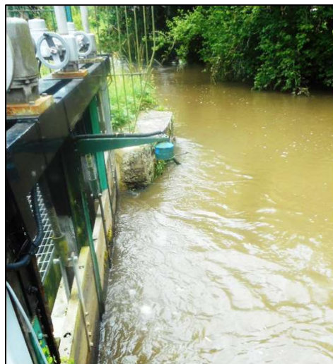
Crue juin 2018 relevés terrain
